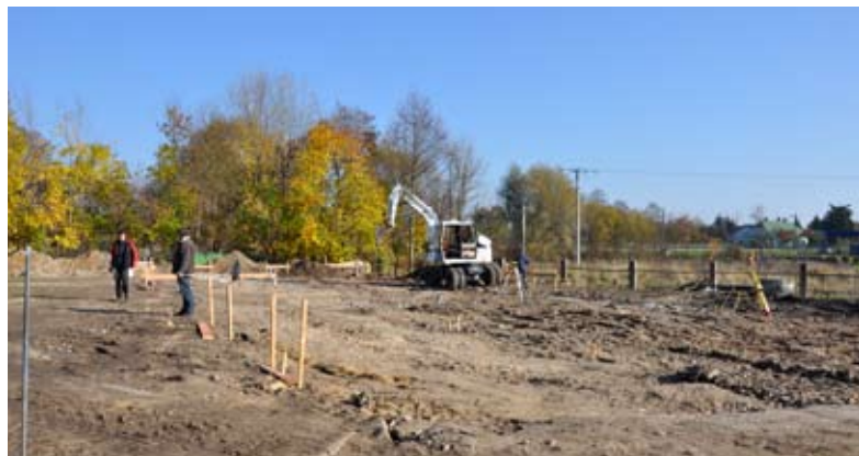
Rozbudowa zaplecza stadionu to największa inwestycja realizowana obecnie w Międzyrzecu Podlaskim
