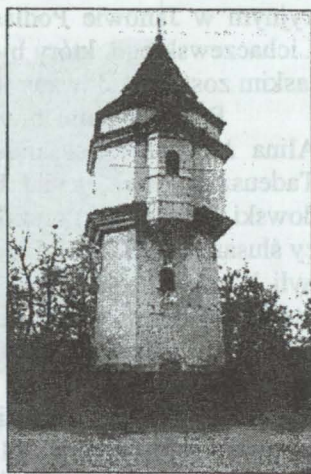
Wieża ciśnień. Stąd „ciuchcia” wyruszała na trasę
