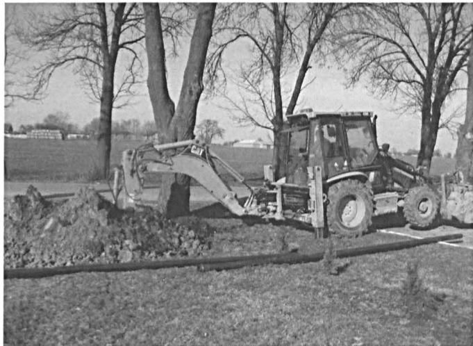
Budowa sieci wodociągowej gminy Jabłoń
