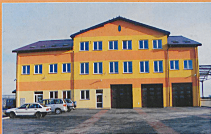
Remont GOK-u w Kąkolewnicy
