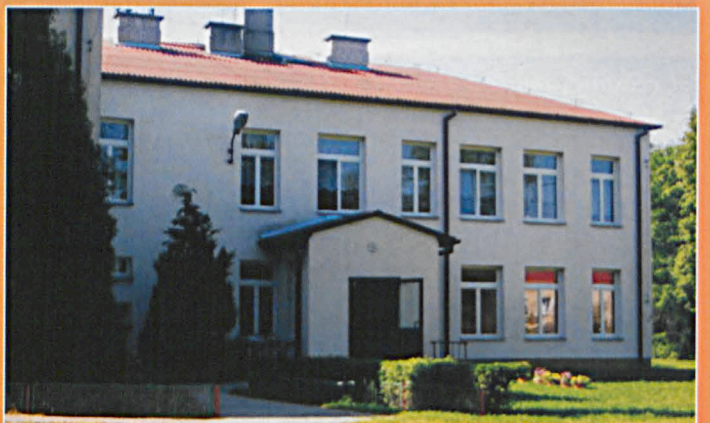
Modernizacja gimnazjum w Olszewnicy
