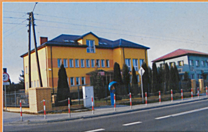
Modernizacja budynku Urzędu Gminy w Kąkolewnicy
