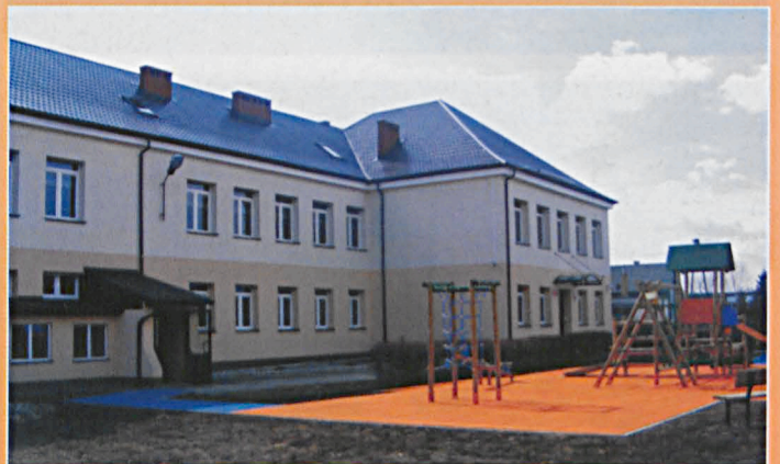
Modernizacja szkoły w Brzozowicy
