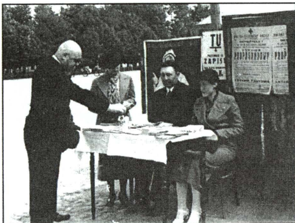
Zbiórka pieniędzy na PCK – z lewej burmistrz Janowice Podlaskiego Jan Caruk. Fot. ok. 1937 r.
