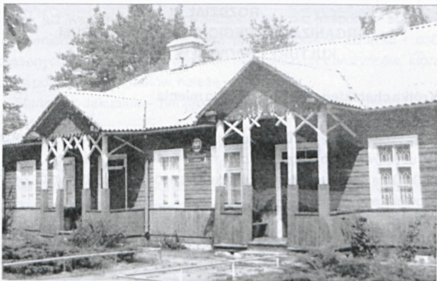
Fot nr 83. Budynek szkoły po uporządkowaniu frontu.
