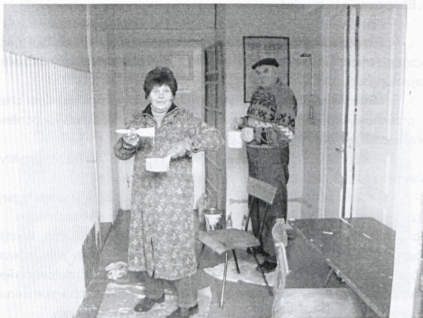
Fot. nr 97. Teresa Mikołajczak i Marian Kraszewski przy malowaniu pomieszczenia.
