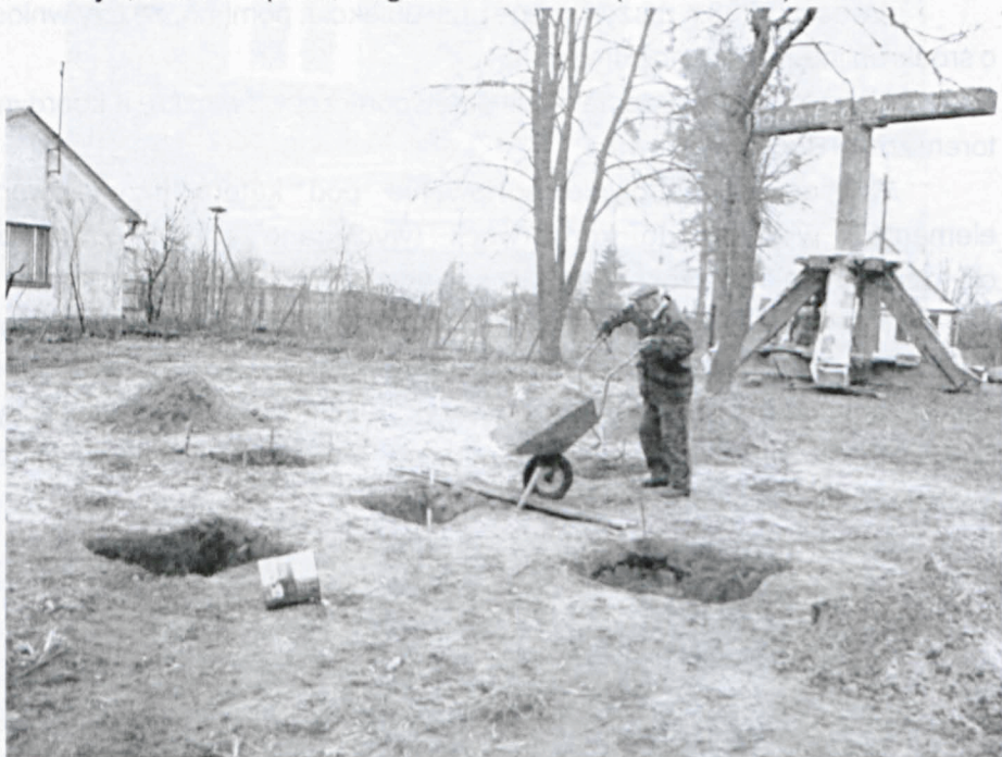
Fot. nr 116. Wykonywanie stabilizacji pod stojan.
