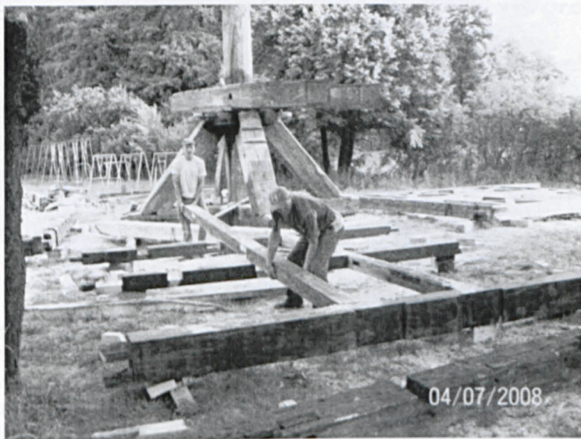
Fot. nr 117. Przygotowanie konstrukcji nośnej
