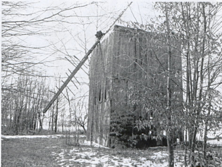
Fot. nr 111. Wiatrak w miejscowości Dubica
