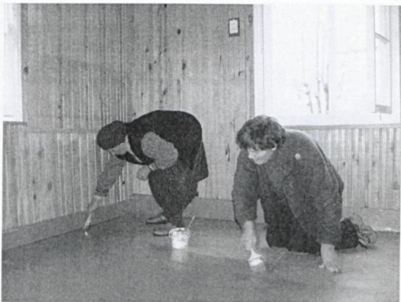
Fot. nr 93. Bronisława Kopkow i Irena Olszewska przy malowaniu podłogi
