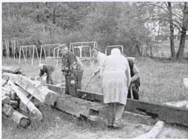
Fot. nr 115. Konserwacja niektórych elementów konstrukcji wiatraka
