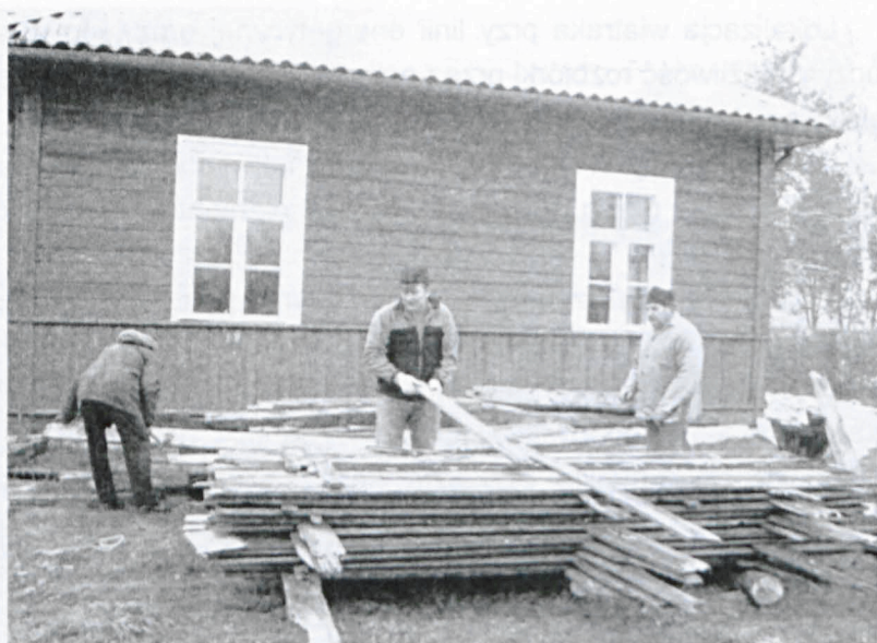
Fot. nr 113. Segregowanie i układanie elementów wiatraka.
