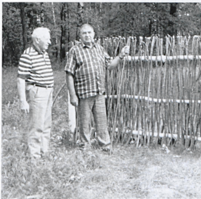
Fot. nr 88. Zbigniew Górski i Jan Kiryk wykonują rekonstrukcję płotku z chrustu
