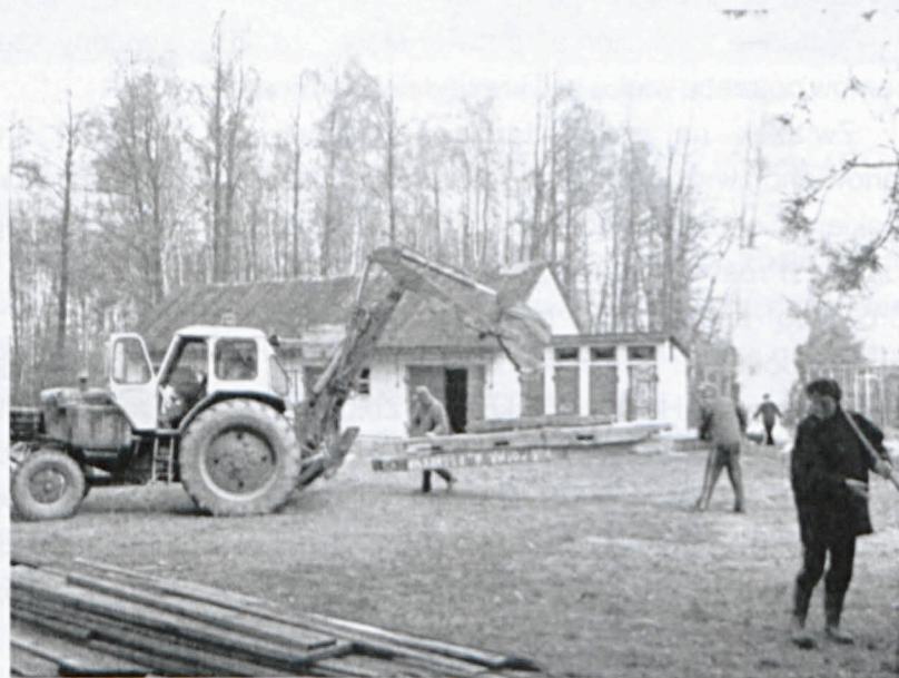
Fot. nr 114. Przewożenie i składowanie elementów wiatraka pod zadaszeniem
