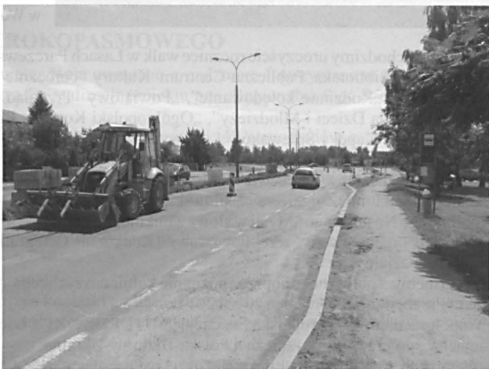
Przebudowa drogi powiatowej na Al. Zwycięstwa w Parczewie
