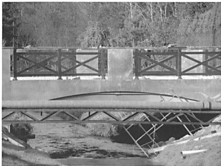
Przebudowa mostu na ul. Bema w Parczewie
