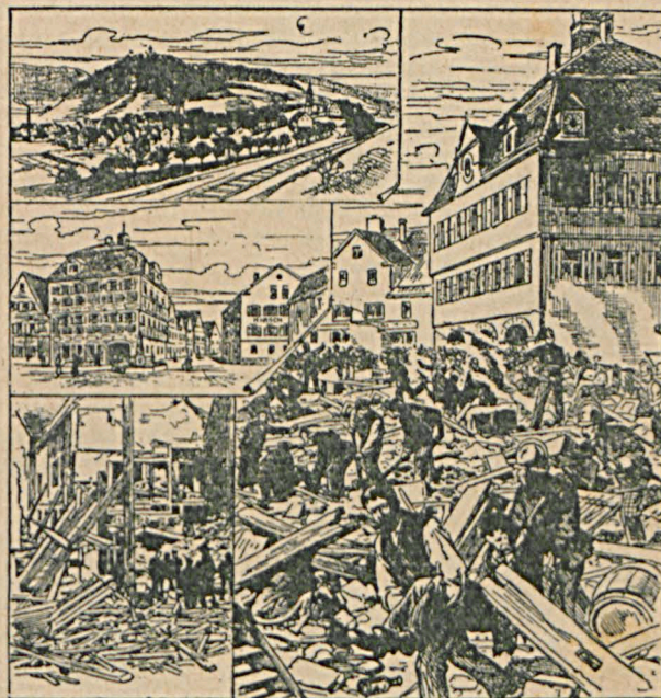
Zapadnięcie hotelu w Negold.
