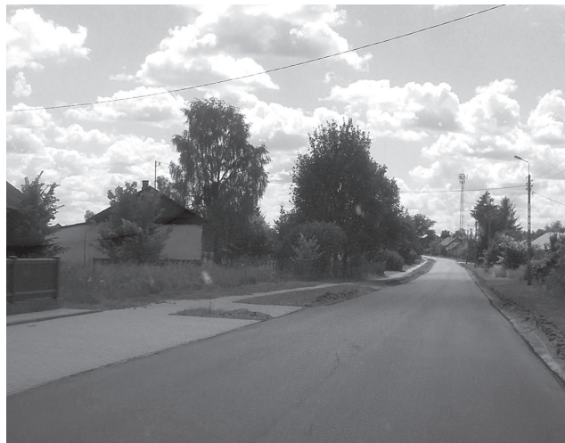
Wyremontowana droga przez Połoski Fot. UG Piszczac
