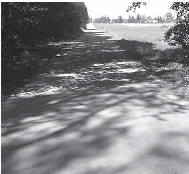
Droga na Raniewo Fot. UG Piszczac
