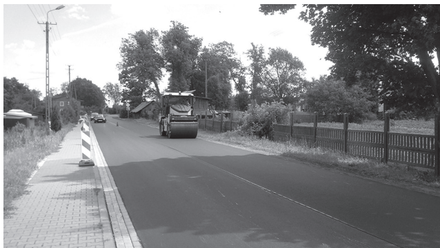
Prace w Chotyłowie Fot. UG Piszczac
