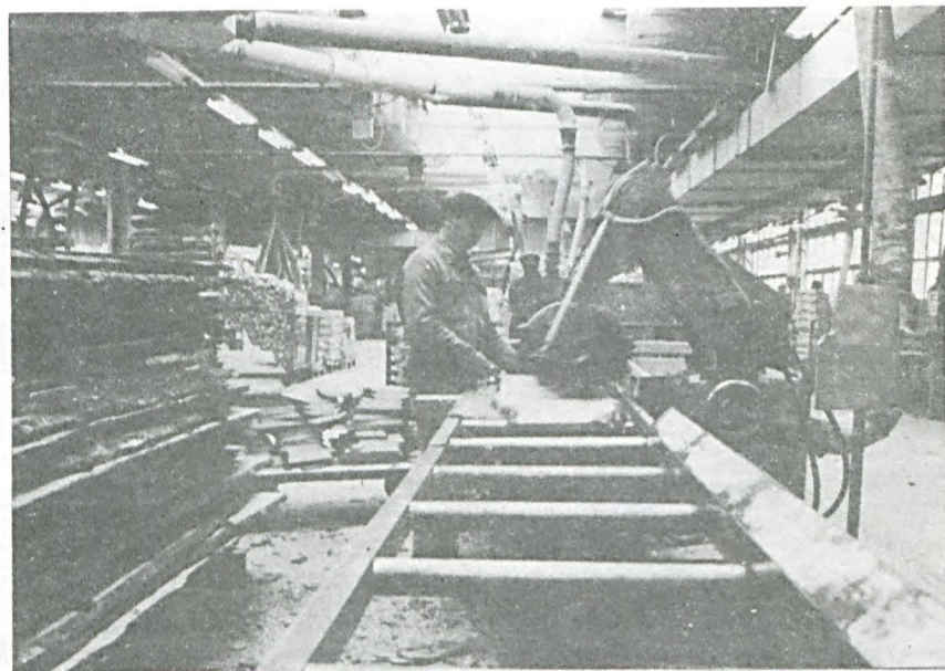
13 Widok ogólny wnętrza hali na Zakładzie Nr 1
