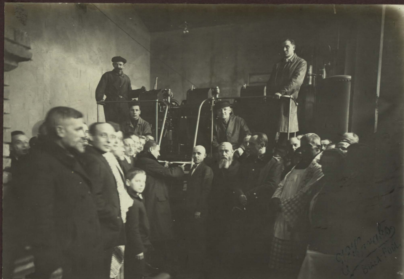
Pojwienie motoru Diesla w Elektrowni M.
