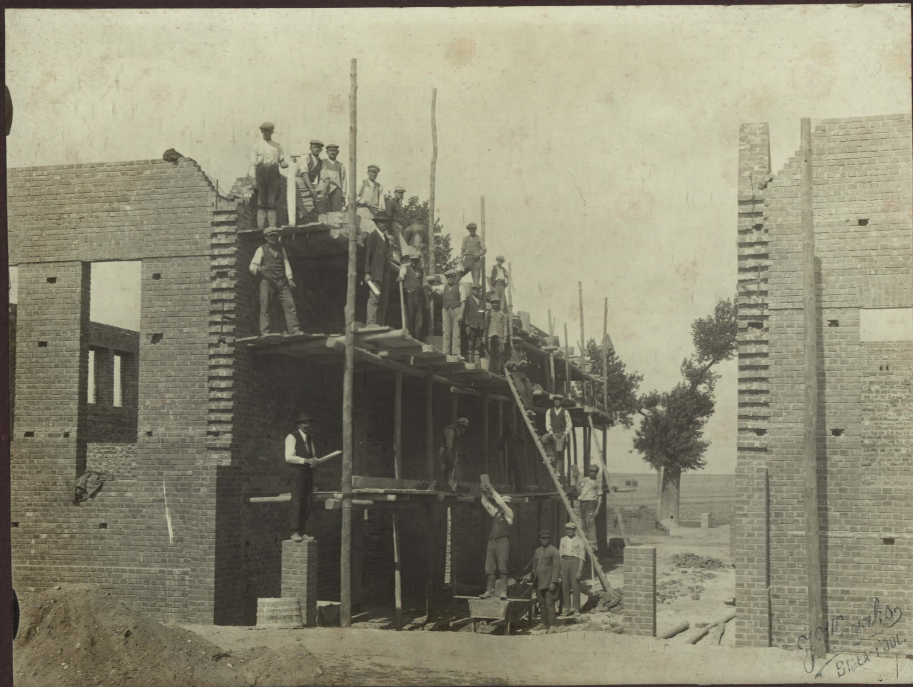
Budowa Rzeźni Miejskiej.
