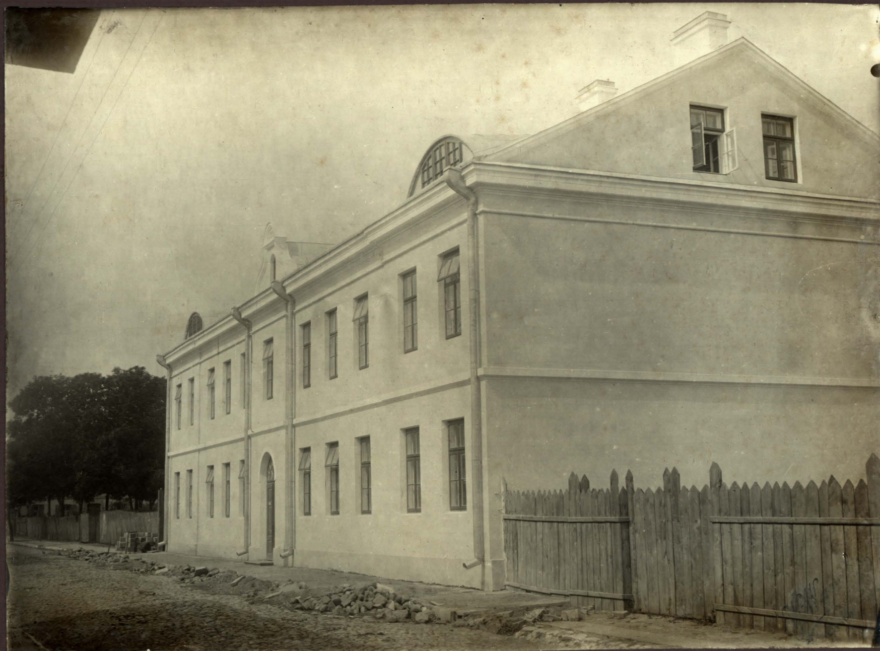
Budynek szkoły przy ul. Szabarskiej.
