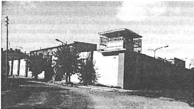
Zakład karny w Białej Podlaskiej. Mur ogrodzenia i wieżyczka wartownicza u zbiegu ulic: Przechodniej, Cichej i Spokojnej.
