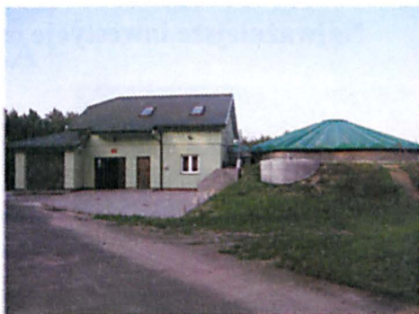
Modernizacja Oczyszczalni ścieków
