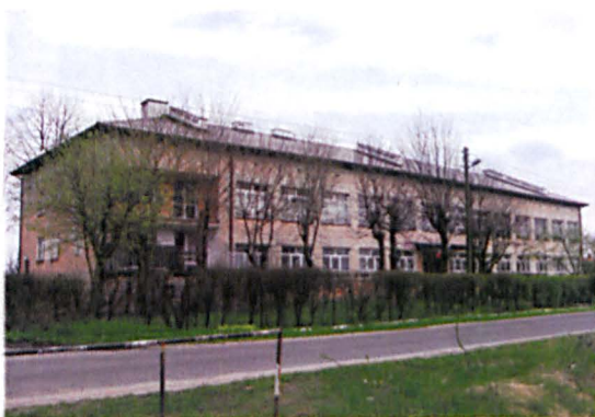
Wymiana dachu na Szkole Podstawowej w Kopytowie
