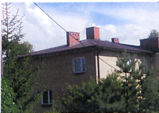
Remont dachu na Ośrodku Zdrowia
