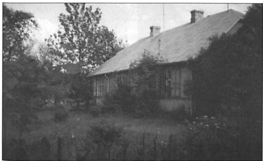
10. Ta plebania była w budowie
