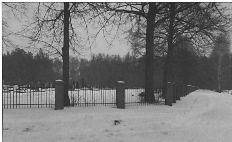
54. Odnowione ogrodzenie cmentarza grzebalnego
