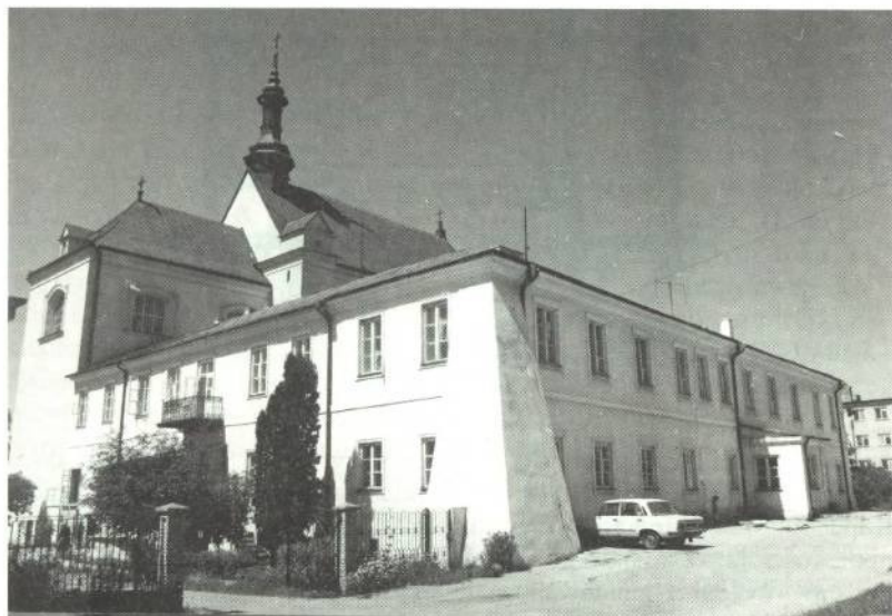
Widok na bryłę kościoła pw. Św. Antoniego w Białej Podlaskiej od strony południowo-wschodniej. Klasztor pocz. XVIII w. arch. Józefat Jeziornicki. Fot. T. Żaczek.
