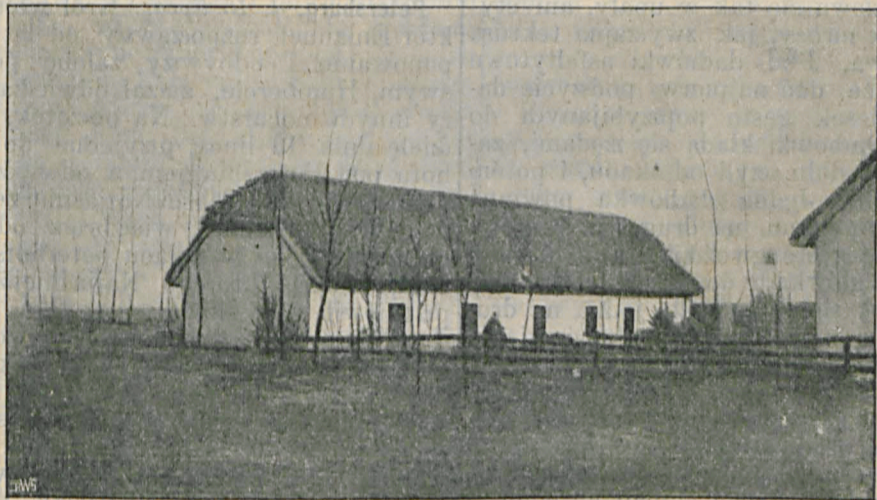
Obory, stajnia, dół i kurnik dla gęsi tegoż gospodarza w Dąbkowicach, pobudowane z piasku pod jedną stęchą przez W. Kierusa w roku 1900. Grubość muru i czterech ścian poprzecznych wewnątrz taka sama jak w domu powyższym. Długość tego budynku 42 łokcie i 12 cali, szerokość 11 ł., wysokość zrębu 4 ł. i 12 c.
