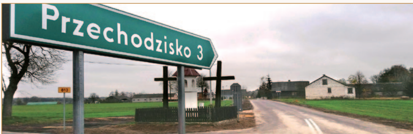
Przebudowana droga powiatowa nr 1122L łączącej miejscowości Zahajki, Przechodzisko i Drelów. Koszt - ok. 930 tys. zł
