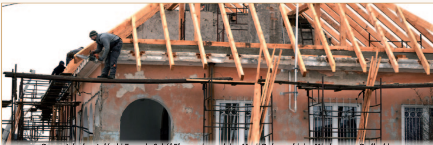
Remont dachu stołówki Zespołu Szkół Ekonomicznych im. Marii Dąbrowskiej w Międzyrzecu Podlaskim
