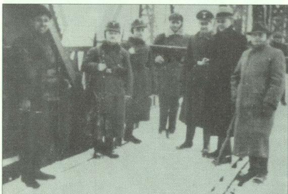
1940 r. Granica między III Rzeszą i ZSRR na moście kolejowym we Fronolowie na Bugu.
