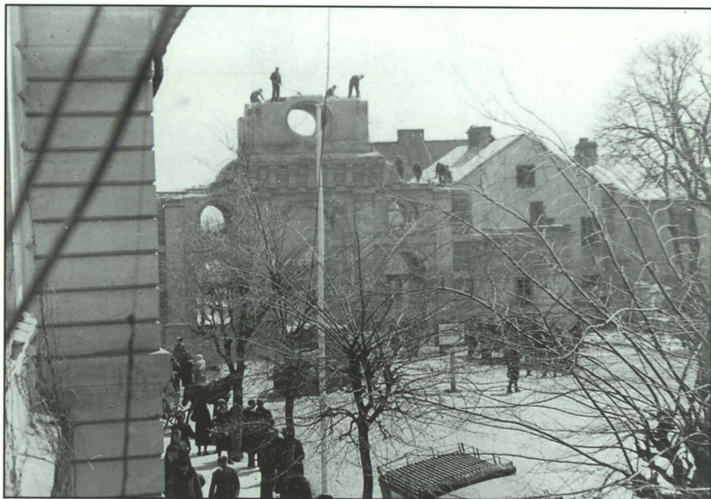
Rozbiórka dzwonnicy nadulicznej w Siedlcach, 12.V.1941 r. Ujęcie z balkonu Starostwa. Fot. H. Lenkowski. (MRS/F/983).
