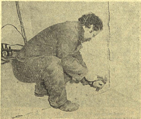
Andrzej Welk jest zaradny. Potrafi wykonać drobne prace murarskie we własnym zakresie.
