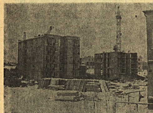
Place budowy białskiej mieszkaniówki. fot. A. Zienuk
