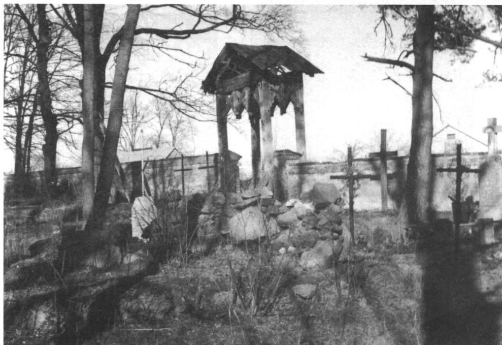
Brama cmentarna w Sycynie – unikalna konstrukcja kratowa z XX w.
