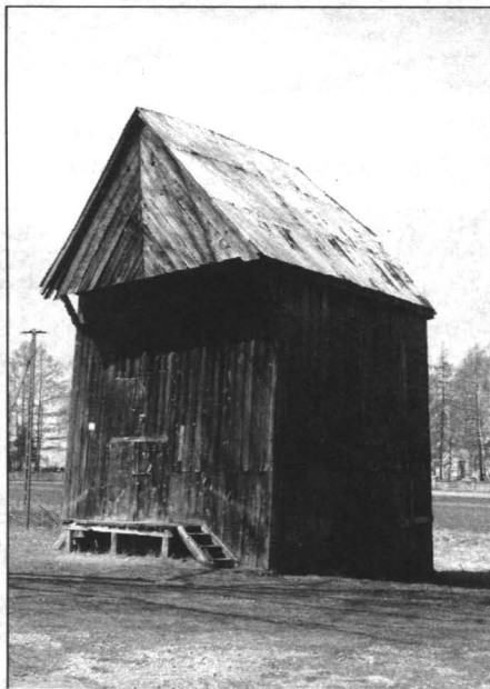
Widok wiatraka od strony ściany frontowej.
