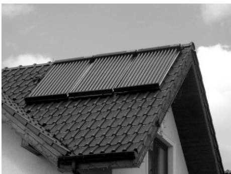
INSTALACJA KOLEKTORÓW SŁONECZNYCH 436 ZESTAWÓW ( W TRAKCIE)
