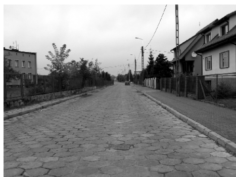
UL. GRANICZNA OD UL. CZERWONEGO KRZYŻA W KIERUNKU BAZY PGKiM( W TRAKCIE REMONTU)
