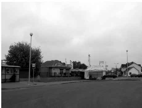
OŚWIETLENIE RONDA PRZY DWORCU PKP ORAZ ULIC: SŁUSZKI, POCIEJA, FLEMINGA, CZARTORYSKICH
