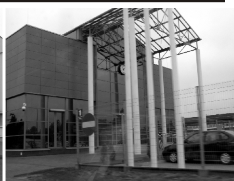
BUDOWA DWORCA MIĘDZYNARODOWEGO PRZY UL. MĘCZENNIKÓW UNICKICH
