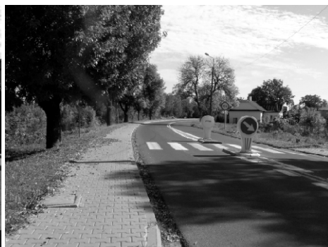
POMOC PRZY BUDOWIE CHODNIKA UL. 3-GO MAJA
