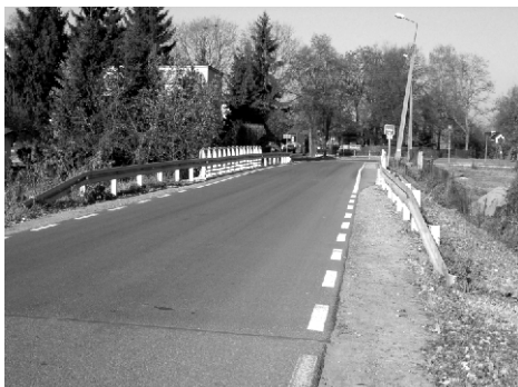
BUDOWA MOSTÓW UL. KODEŃSKA
