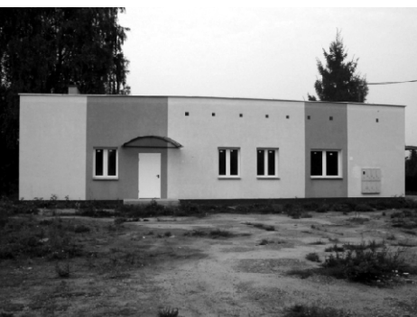
REMONT STAREJ WETERYNARII PRZY UL. PIŁSUDSKIEGO NA MIESZKANIA KOMUNALNE
