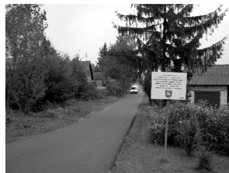
UL. ŻEROMSKIEGO - MODERNIZACJA DROGI DOFINANSOWANEJ Z FUNDUSZU OCHRONY GRUNTÓW ROLNYCH
