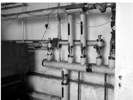
WYMIANA CENTRALNEGO OGRZEWANIA W OCHOTNICZEJ STRAŻY POŻARNEJ
