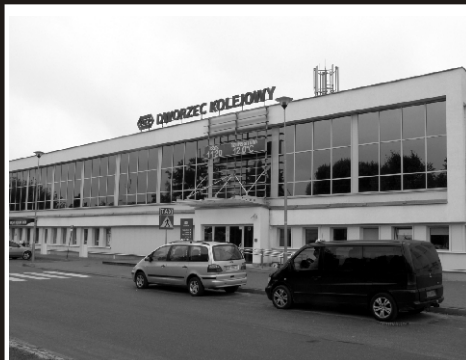
GENERALNY REMONT DWORCA KOLEJOWEGO
