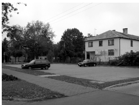
POMOC PRZY BUDOWIE PARKINGU UL. WOJSKA POLSKIEGO
