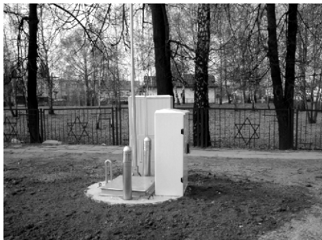
BUDOWA KANALIZACJI MIEJSKIEJ 97% MIASTA
