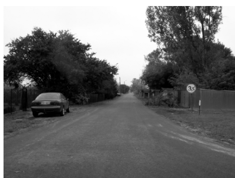
ASFALT UL. E. ORZESZKOWEJ IWESTYCJA WSPÓLNOTY WSI BŁOTKÓW DUŻY
