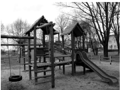
BUDOWA PLACU ZABAW PRZY UL. SIENKIEWICZA
