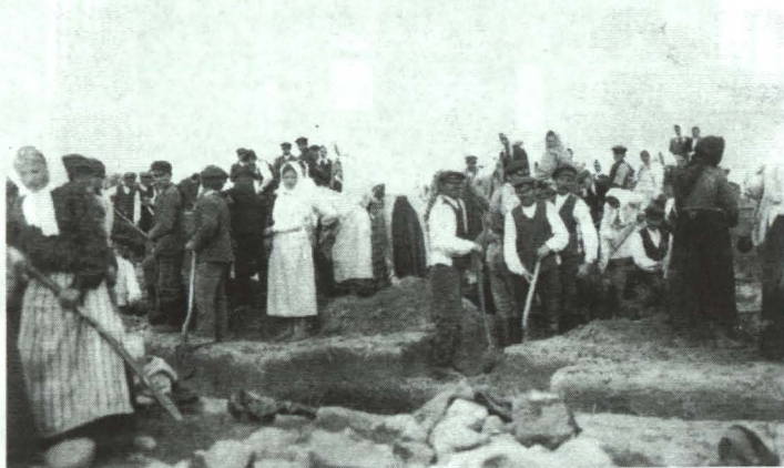
Prace przy budowie kościoła w Konstantynowie. Podobnie było w Kornicy
