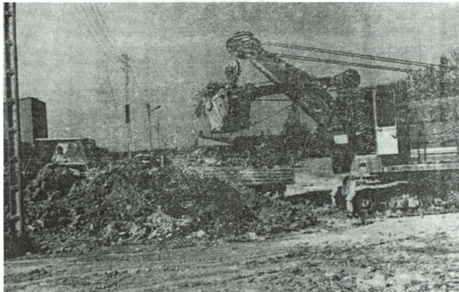
Lata siedemdziesiąte. Prace mechaniczne wykonywane w czynie społecznym w Kornicy
