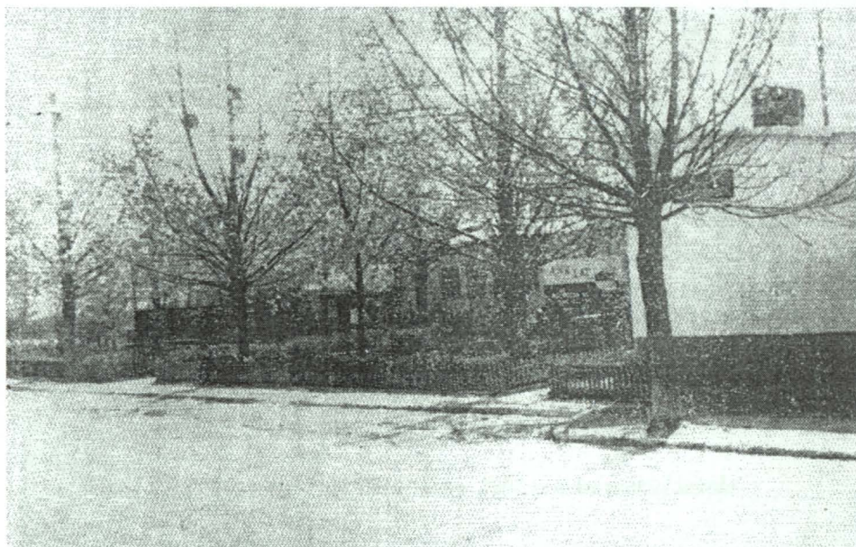
Budynek biurowy KZK w Kornicy (stan z 1986 r.)
