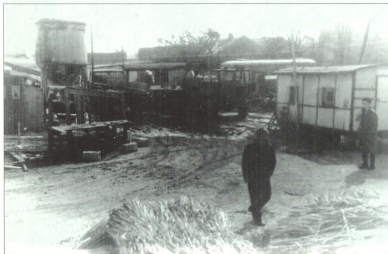
Pan kierownik budowy jak zwykle na „posterunku”.
