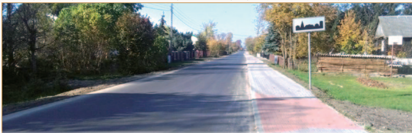
Ukończona przebudowa drogi powiatowej Nr 1012L (Kownaty) gr. woj. – Rogoźnica. Łączny koszt to 1 842 915,58 zł
