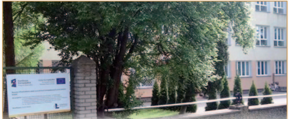
Zakończona modernizacja ZST w Międzyrzeczu Podlaskim w ramach projektu Rozwój infrastruktury szkół zawodowych prowadzonych przez powiat biański. Ogólna wartość projektu to kwota 3 528 411,72 zł
