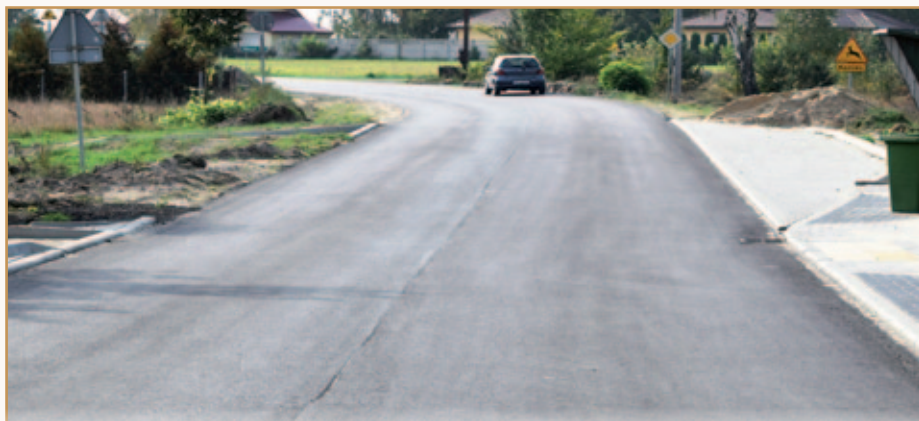
Przebudowę drogi powiatowej Nr 1036L na odcinku Biała Podlaska (ul. Francuska) – Rokitno w ramach projektu Wygodniej, szybciej, bezpieczniej
