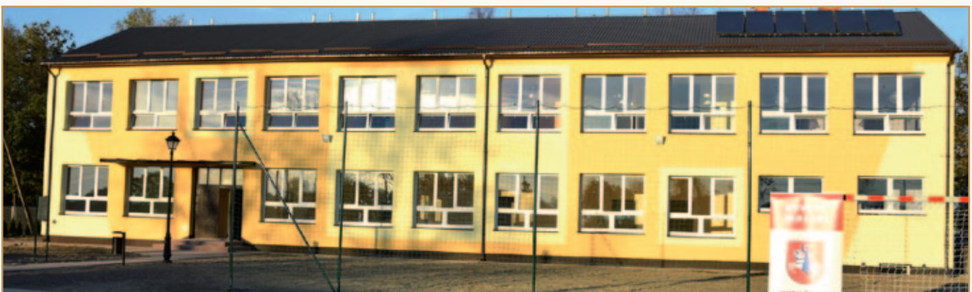
Adaptacja byłej szkoły podstawowej w Maniach do potrzeb placówki opiekuńczo - wychowawczej z mieszkaniami chronionymi o wartości ponad 2 mln 870 tys. zł
