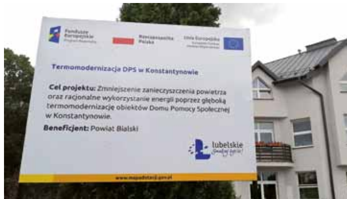
Termomodernizacja Domu Pomocy Społecznej Konstancinów
