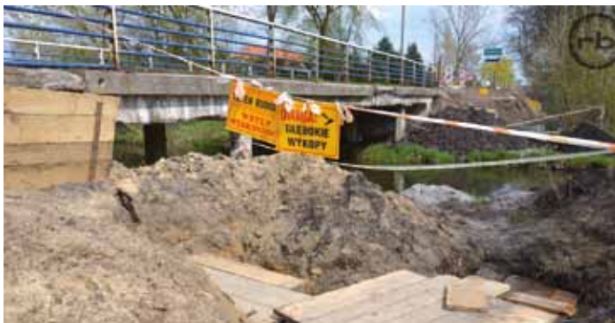
Przebudowa drogi Biata Podlaska Grabanów Rokitno - budowa kładki pieszo rowerowej na rzece Klukówce
