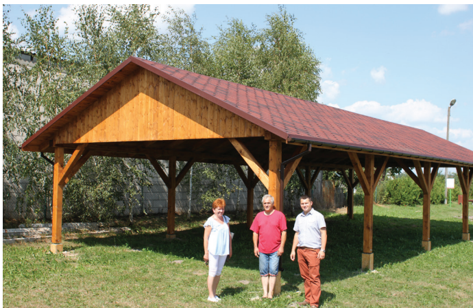
Budowa altany w Sitnie
