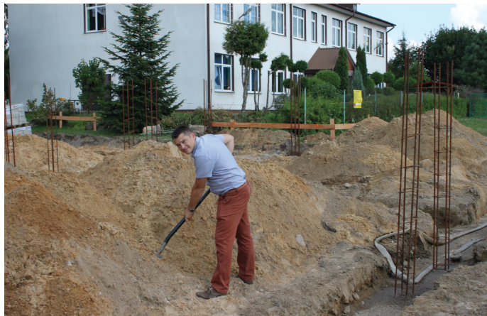
Budowa remizy i świetlicy wiejskiej w Woli Chomejowej
