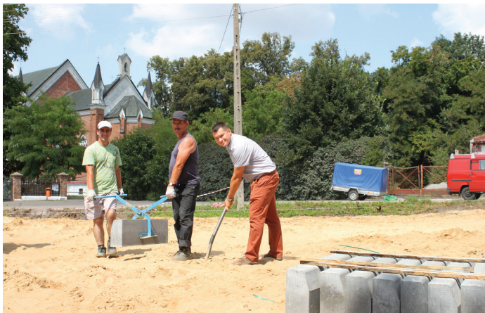
Budowa parkingu w Woli Osowińskiej
