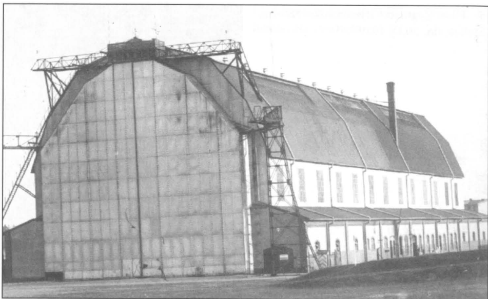
17. Toruń, 1927 r. Hala o wym. 101 x 25 x 23 (wys.) m zbudowana w 1911 r. przez firmę J. Gollnow & Sohn ze Szczecina dla sterowców Zeppelin. Na jej bazie zorganizowano w Toruniu 1bb. Zdemontowana w 1954 r.
