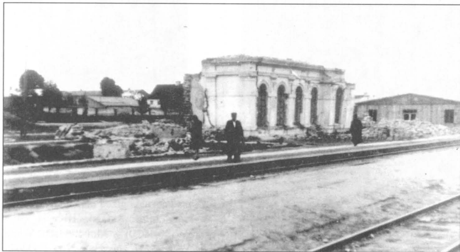
134. Platerów, zniszczony budynek dworca osobowego. Stan z 29.07.46 r. (Rejonowy Ośrodek Informacji Naukowej, Technicznej i Ekonomicznej w Warszawie, XXII / 13a).
