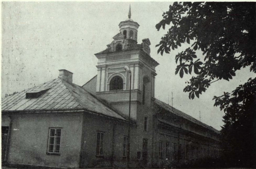
Ryc. 20 Oficyna zachodnia i wieżyczka galerii. Widok od strony południowej.
