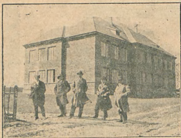
Budowa Szkoły Powszechnej w Krasewie.
