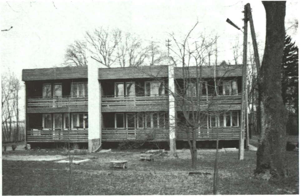
Pod koniec lat 80. zbudowano Dom Nauczyciela
