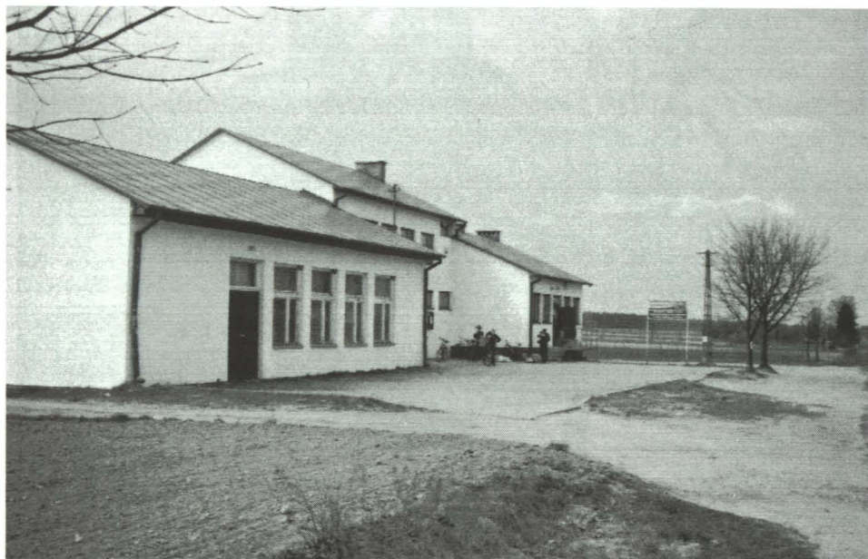
W 1999 r. zbudowano nową remizę strażacką, kaplicę i sklep
