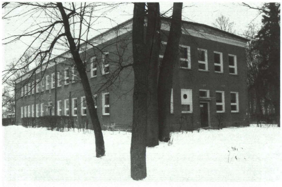
W 1997 r. dokonano remontu szkoły
