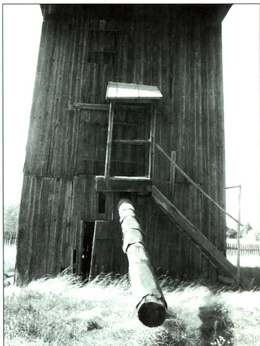
Widok wiatraka od strony ściany frontowej z zachowanym dyszlem.
