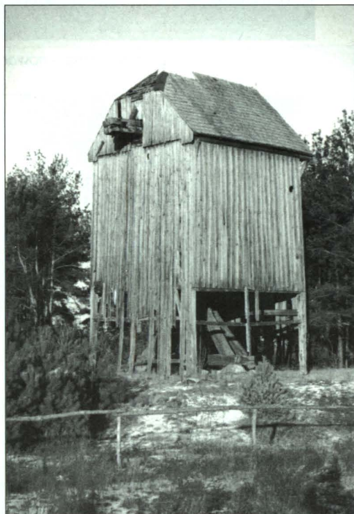
Widok wiatraka od strony ściany bocznej i odwietrznej.
