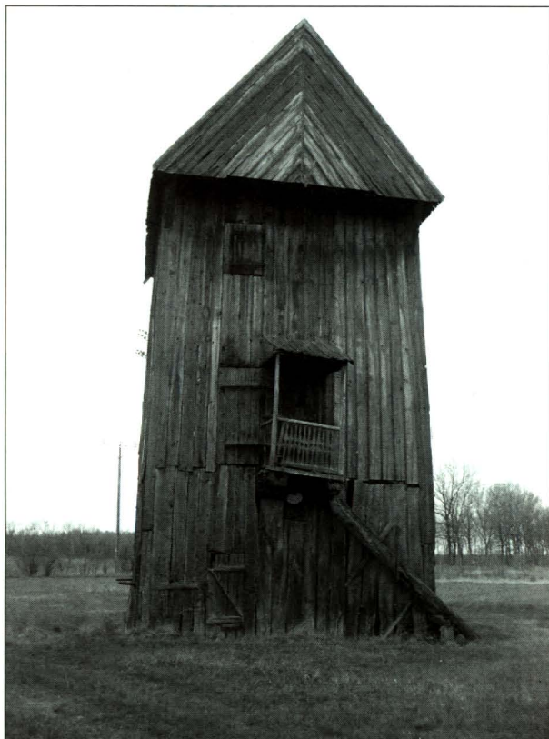
Widok wiatraka od strony ściany odwietrznej.
