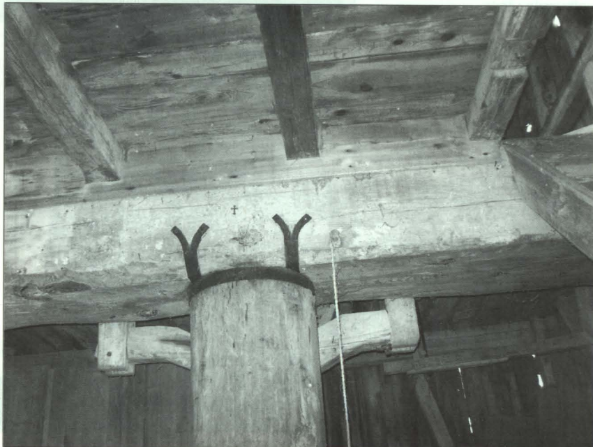
Wnętrze wiatraka – widoczna belka mączna ze sztembrem.
