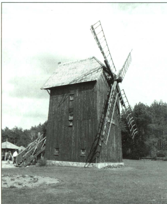
Widok wiatraka od strony ściany odwietrznej.
