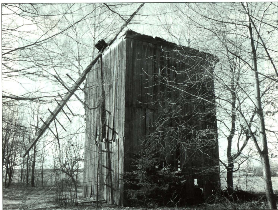
Widok wiatraka od strony ściany odwietrznej.
