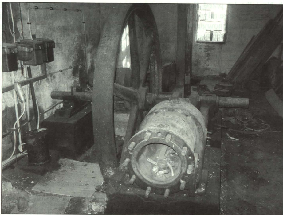
Wólka Zabłocka – wnętrze młyna z silnikiem motorowym.
