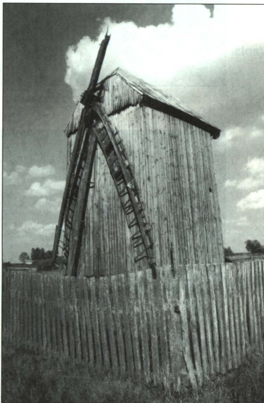
Widok wiatraka od strony ściany odwietrznej.
