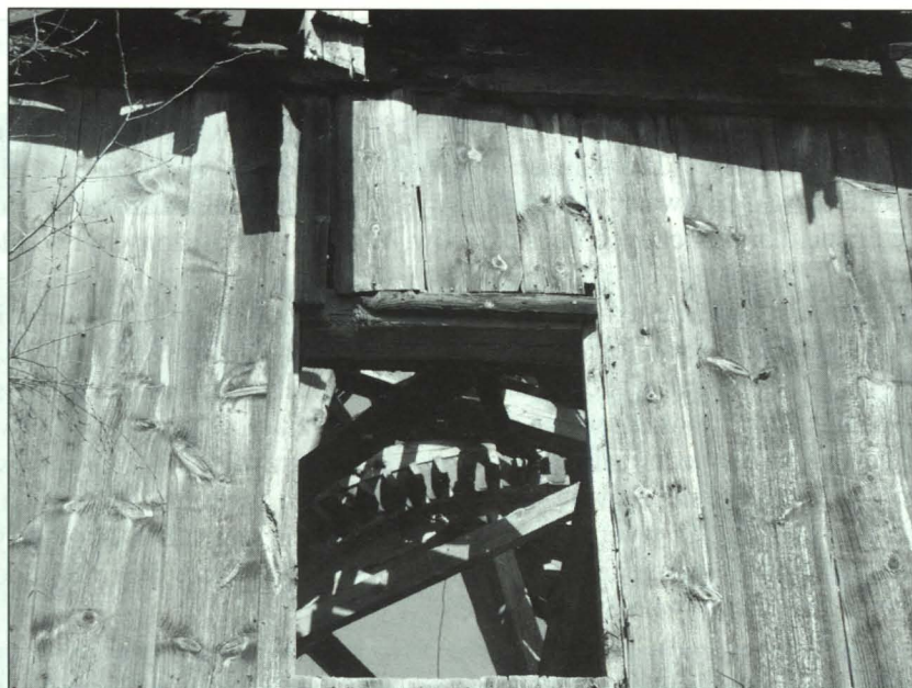
Widok na pozostałość po drzwiach zbożowych.
