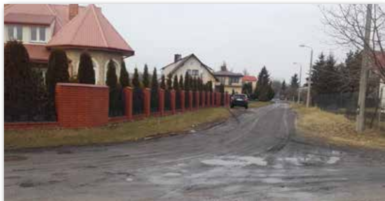
Na osiedlu „Za torami” ruszy budowa ulicy Asnyka (I etap)
