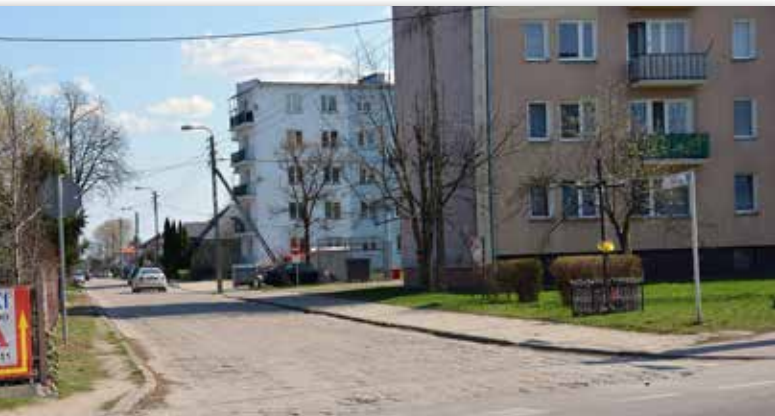
Niebawem rozpocznie się pierwszy etap budowy ulicy Pułaskiego
