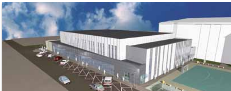
Hala sportowo-widowiskowa przy Jedynce, to marzenie wielu międzyrzeckich środowisk
