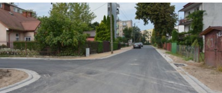
Ulica Pułaskiego po remoncie
