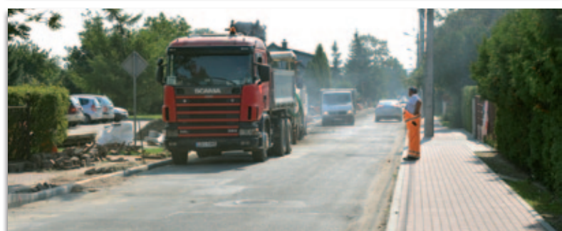
Trwają prace na ul. Zarówie
