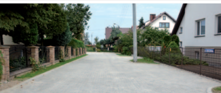
Ulica Akacyjowa po remoncie
