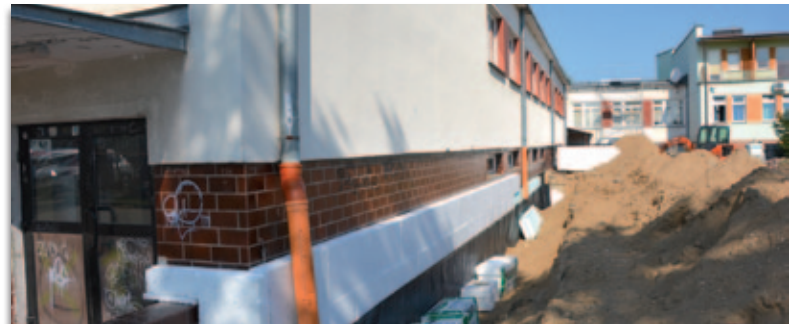
Trwa termomodernizacja pływalni
