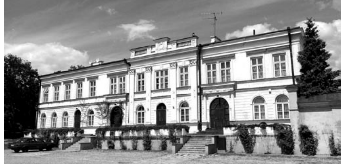
Будинок Холмського православного Свято-Богородичного братства, у якому діяв також Церковно-археологічний музей, організований 1882 року (в його збірці були також архітектурні елементи споруд, збудованих Данилом Романовичем (загинув під час евакуації влітку 1915 року). Фото Ю. Гаврилюка.
