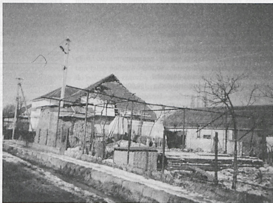
W tym miejscu stał drewniany dom, który zniosła woda
