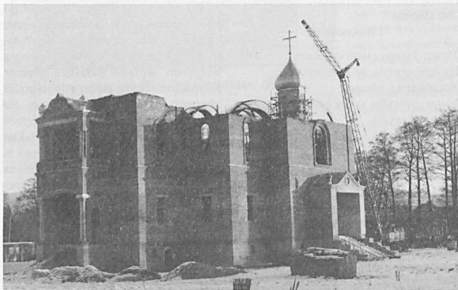
Budowana cerkiew św. proroka Eliasza w Irszawie
