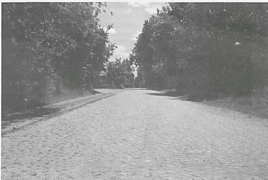
Kiedy na tej drodze pojawi się asfalt?
