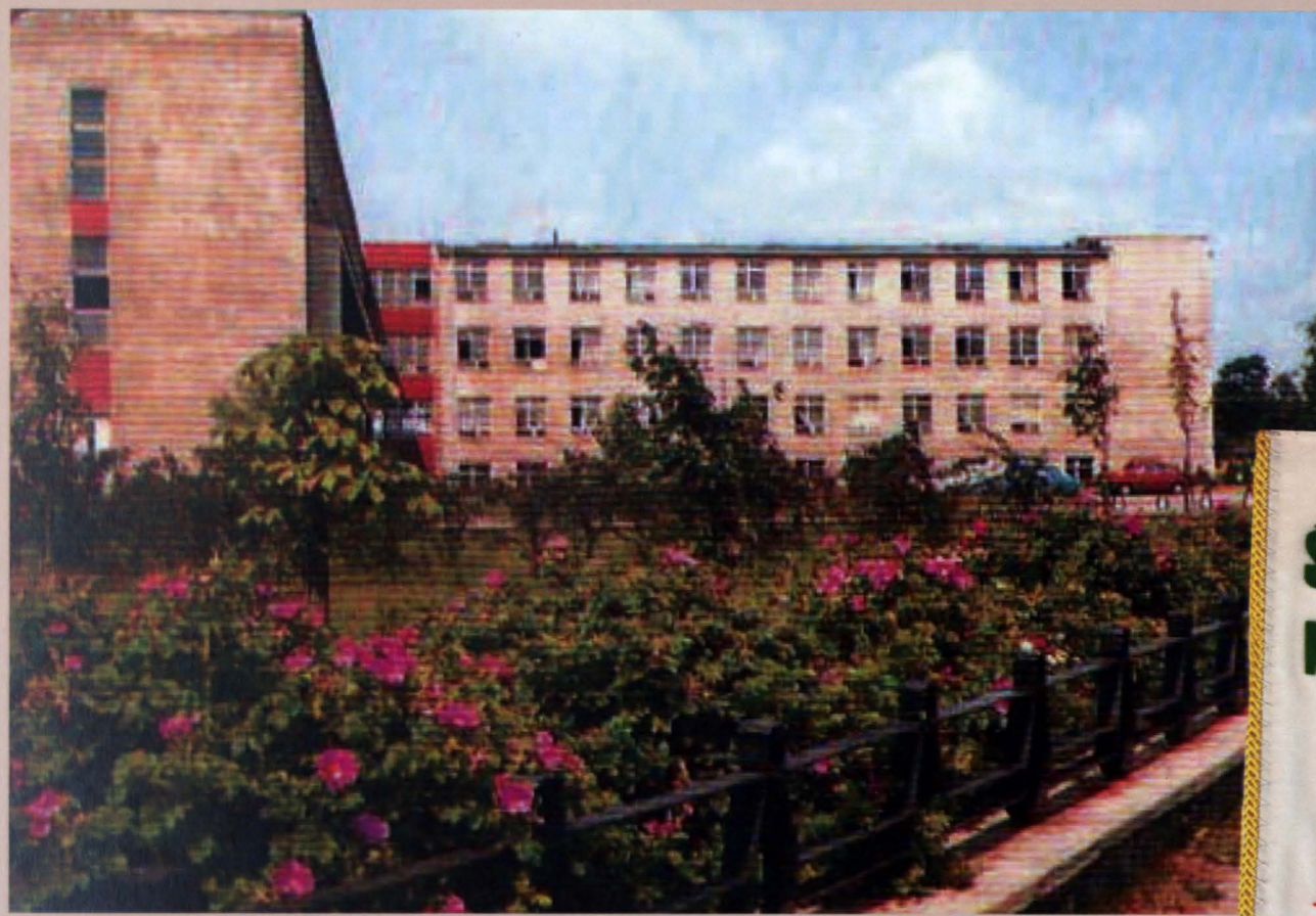
Fragment budynku głównego Filii AWF w Białej Podlaskiej - ok. roku 1980. (fot. ze zbiorów autora)
