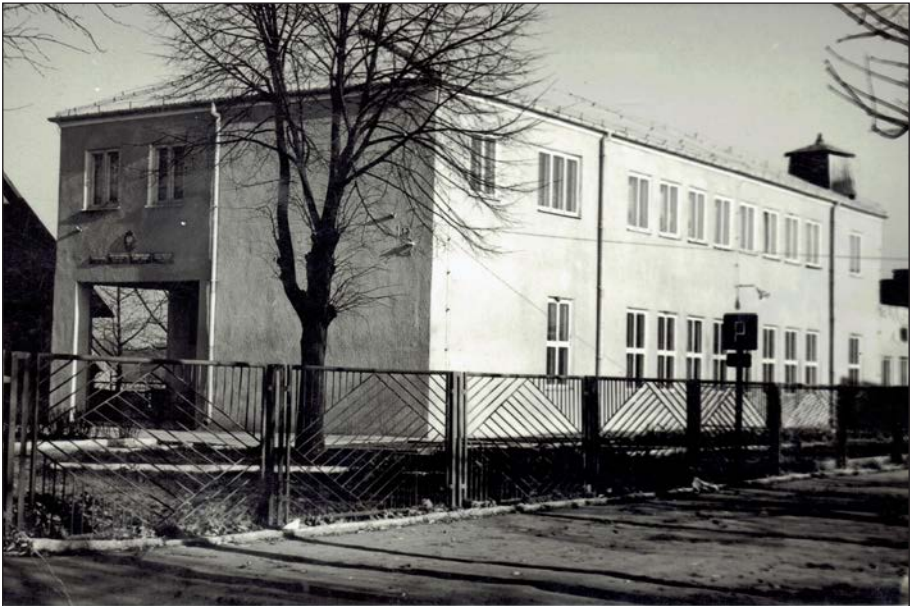
Budynek Urzędu Gminy - początek lat 70-tych
