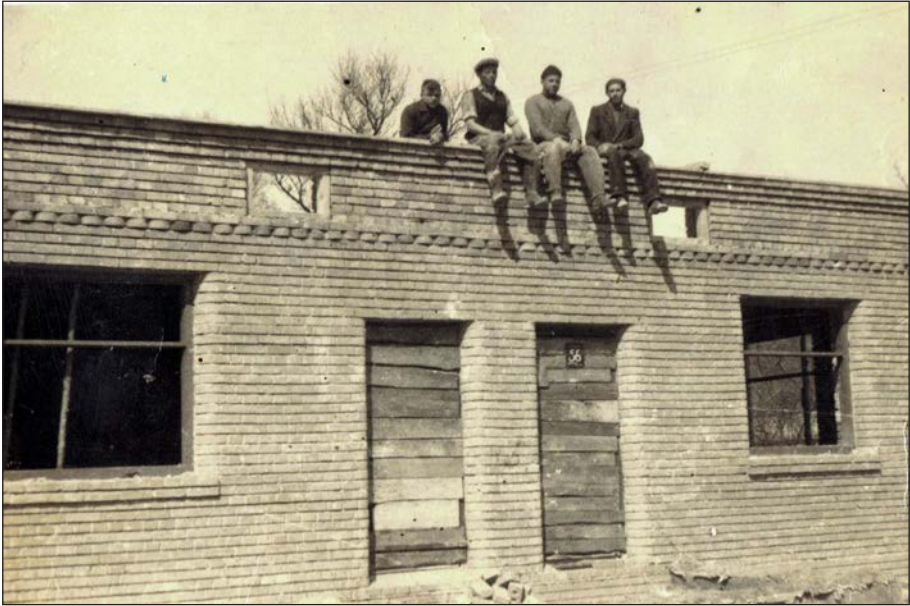
Budowa domu Ireny i Mieczysława Misiejuków
