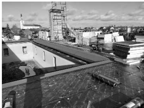
Prace remontowe na dachu budynku stacji uzdatniania wody przy ul. Kodeńskiej
