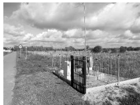
Przepompownia ścieków na skrzyżowaniu ulicy Sportowej i Łąkowej
