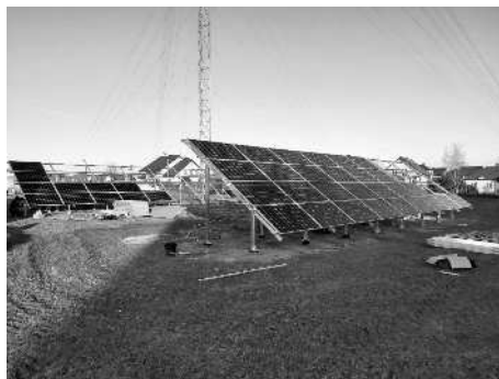
Budowa instalacji fotowoltaicznej na stacji uzdatniania wody przy ul. Kodeńskiej.
