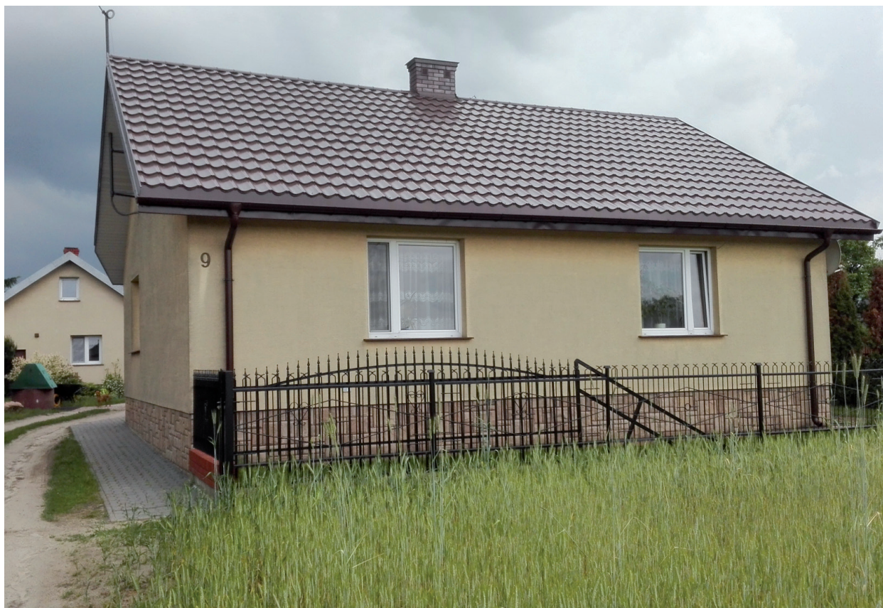
Nowe pokrycie dachowe uzyskane z projektu w miejscowości Rzeczycza
