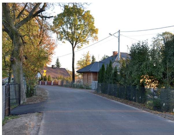
Fragment wyremontowanej drogi w Pościszach Starych
