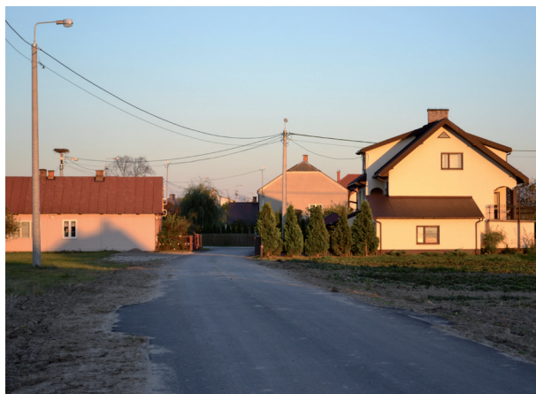
Nowa nawierzchnia asfaltowa w Wólce Krzymowskiej
