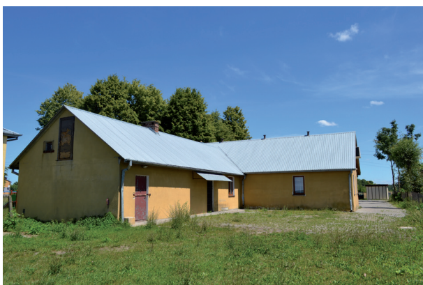
Budynek Domu Ludowego w Berezce przed remontem
