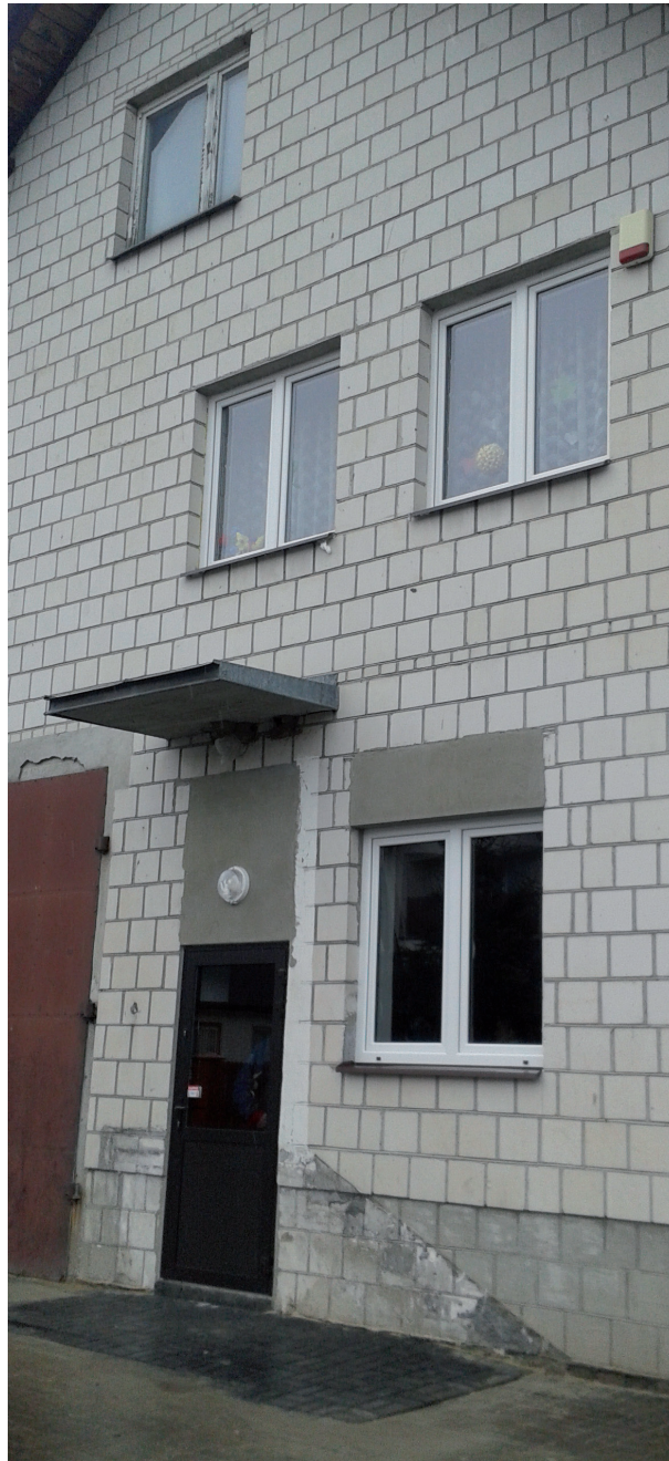
Przebudowa pomieszczeń remizy strażackiej w Żabcach. Wartość inwestycji: 47 530,67 zł. Na zdjęciu wymienione na nowe drzwi zewnętrzne oraz stolarka okienna
