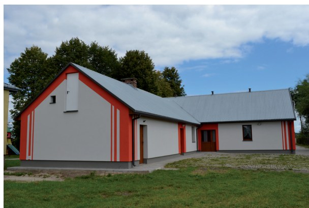
Przebudowa Domu Ludowego w Berezce. Wartość inwestycji: 89 500 zł
