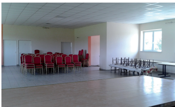
Remont budynku OSP w Sitnie z przeznaczeniem na funkcjonowanie świetlicy wiejskiej. Wartość inwestycji: 6 200 zł
