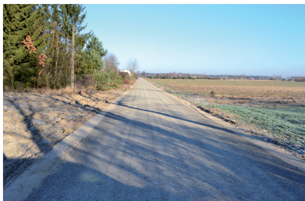
Budowa drogi w miejscowości Misie. Wartość inwestycji: 152 524,48 zł
