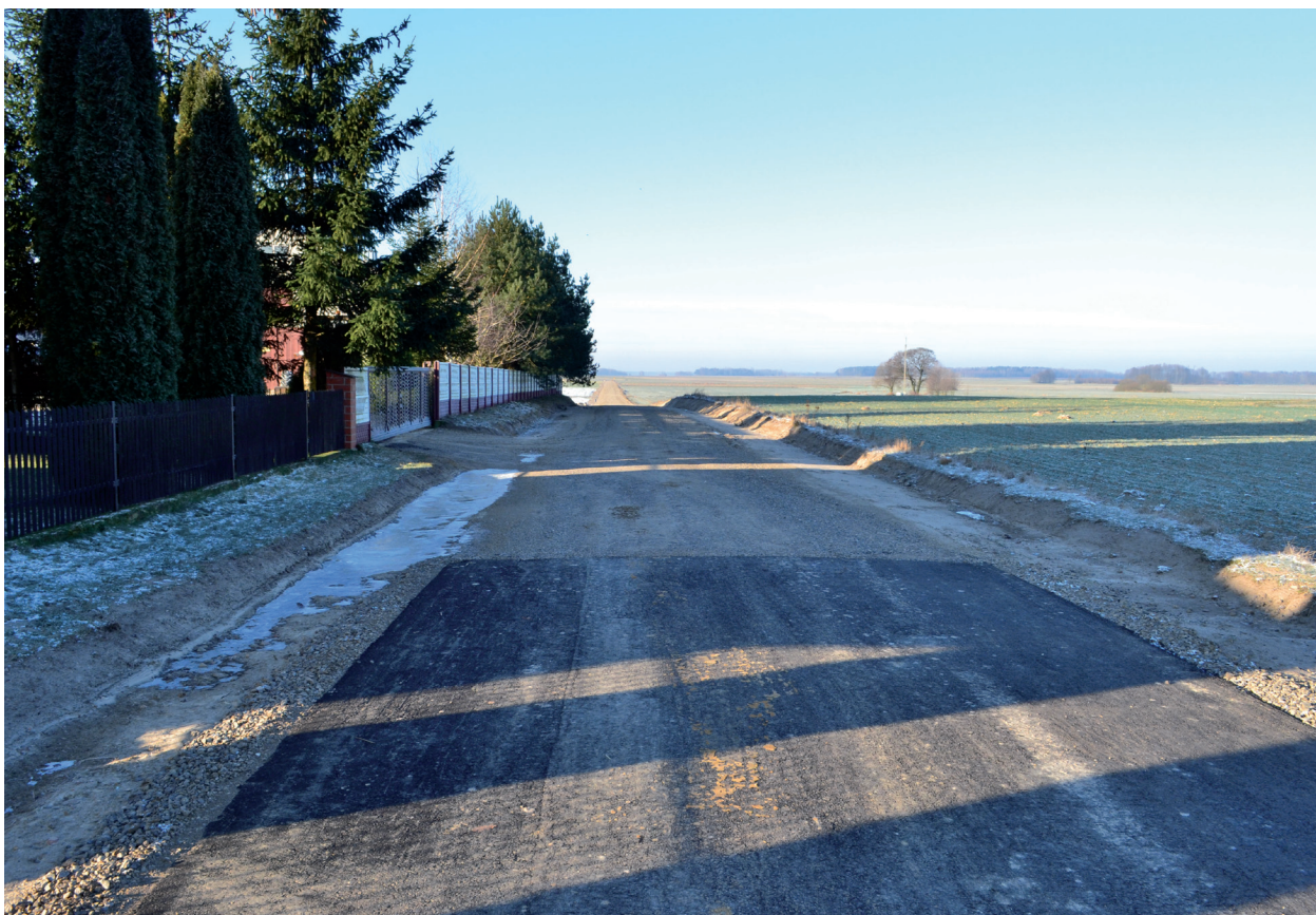
Budowa drogi w miejscowości Łuniew. Wartość inwestycji: 202 389,81 zł
