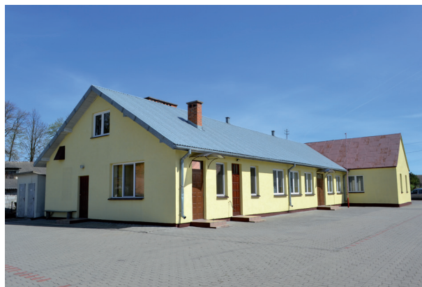
Budynek remizy strażackiej w Krzewicy przed rozbudową
