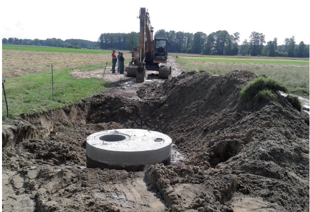
Budowa sieci wodociągowej łączącej miejscowości Tłuściec i Krzewicę na terenie Gminy Międzyrzec Podlaski. Wartość inwestycji: 226.997,32 zł
