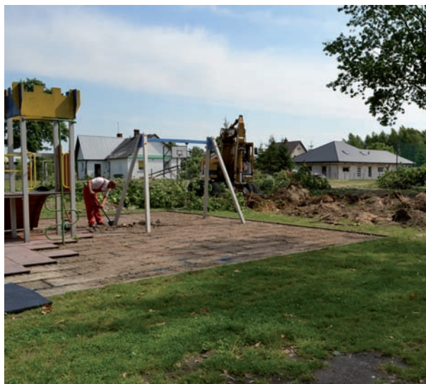
Roboty związane z budową pierwszego przedszkola w gminie ruszyły pełną parą
