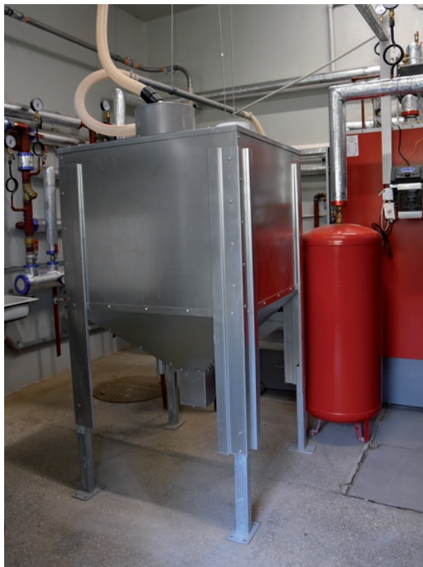
Termomodernizacja – szkoła podstawowa w Rudnikach
