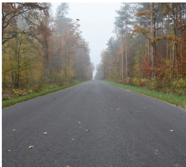
Przebudowana droga w Utrówce
