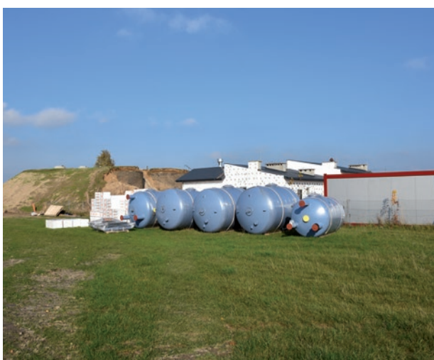
Fragment budynku technologicznego oraz zbiorniki do oczyszczania wody
