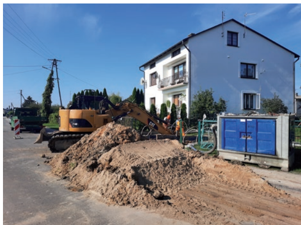
Budowa sieci kanalizacji w Wysokim przy ul. Rolniczej
