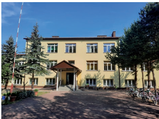
Nowa elewacja i stolarka okienna w szkole podstawowej w Rudnikach
