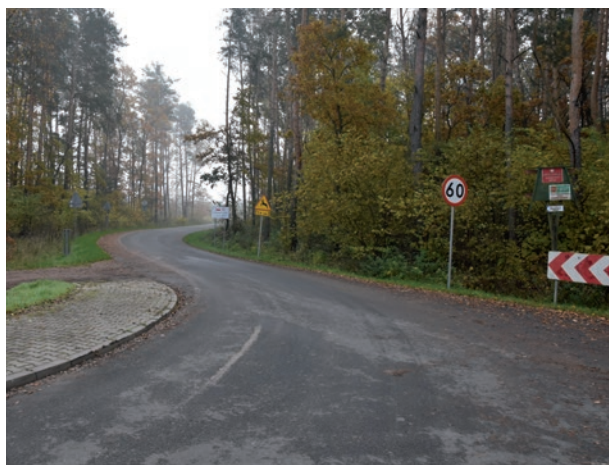
Budowa i przebudowa prowadzącej przez Utrówkę drogi powiatowej nr 1119L Sitno-Szachy przebiegała na odcinku od 1,182 kilometra do 5,338 kilometra
