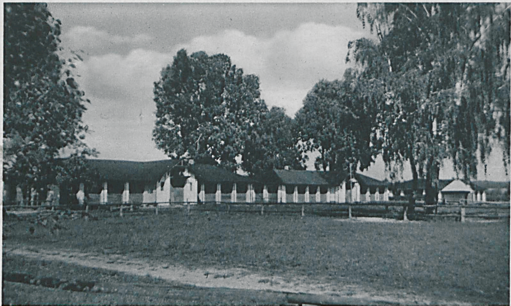
Die Mutterstutenställe des Hauptgestüts Janow-Podlaski
