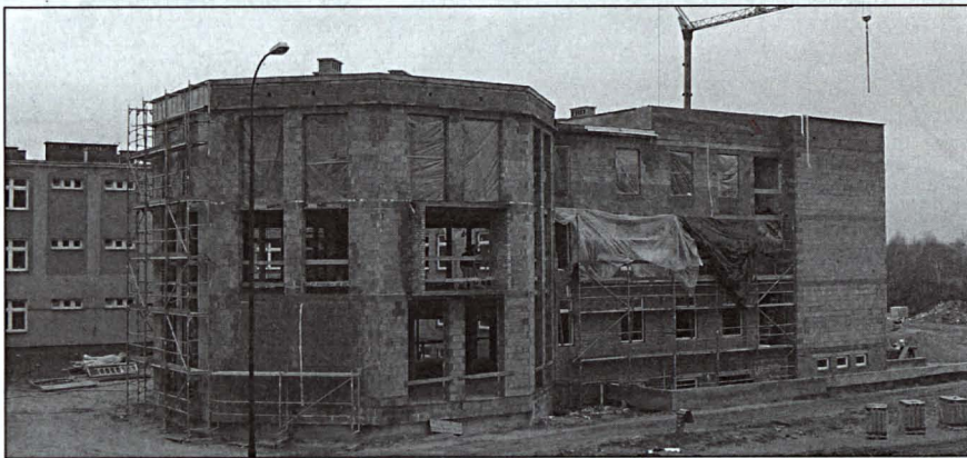
Tak powstaje nowa siedziba Izby Celnej w Białej Podlaskiej
