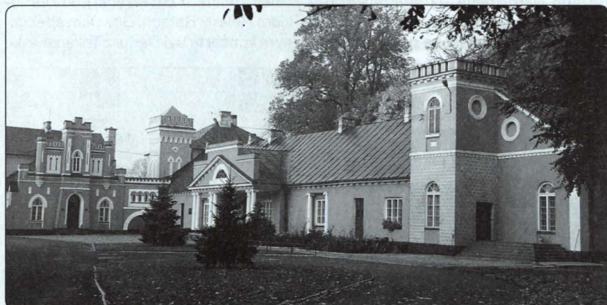
Elewacja wschodnia w stylu neogotyckim. Dachy pałacu są dwuspadowe, nad pawilonem zachodnim i wieżami zaś czterospadowe. Z kolei nad pawilonem wschodnim kryte blachą
