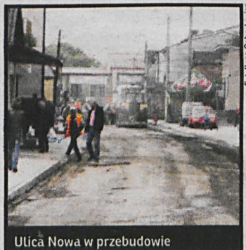
Ulica Nowa w przebudowie
